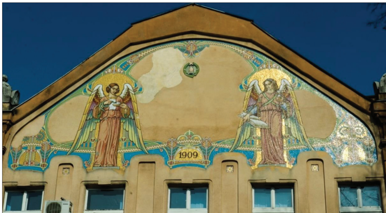
Слика 2. Детаљ улице фасадe некадашње Управне зграде Градске болнице у Новом Саду; извор: лична колекција проф. др Дејана Иванова Figure 2. Detail of the street facade of the former Administrative Building of the Novi Sad City Hospital; source: personal collection of Prof. Dejan Ivanov, M.D.
